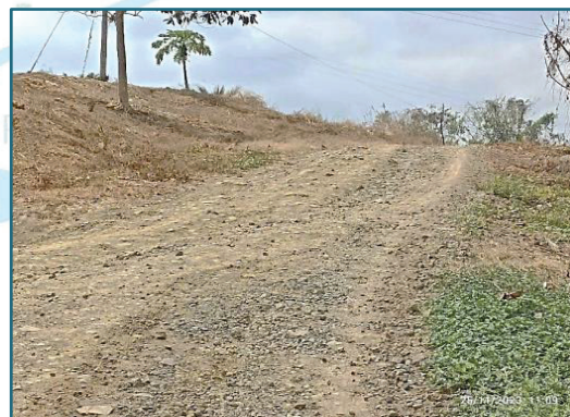
Vías con capa de rodadura Lastre
