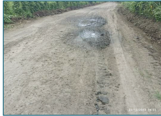
Vías con capa de rodadura Tierra
