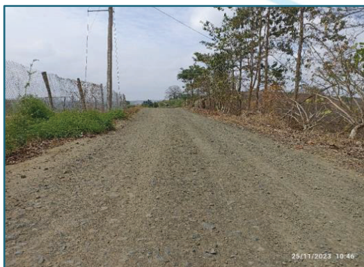
Vías con capa de rodadura Lastre
