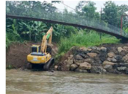
colocación de 300 m3 de piedra escollera en el puente colgante San Jacinto
