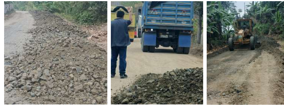
colocación de 300 m3 de piedra escollera en el puente colgante San Jacinto
