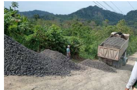
material fino para mejorar tramo crítico - comunidad San Jacinto
